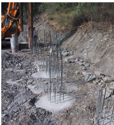
Foto n° 10: La realizzazione dei pali in calcestruzzo armato (nel particolare diaframma lineare)
