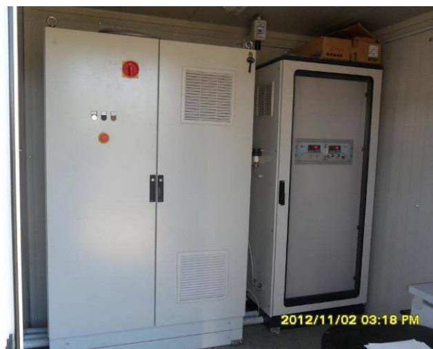
Foto 20: Sistema di monitoraggio Nuovo sistema di analisi del biogas abbinato alla regolazione della captazione (CE-2) e funzionamento del nuovo motore
