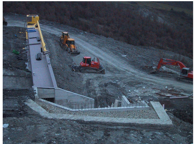
Foto n° 7: Impermeabilizzazione dello scatolare di base della vasca 7
