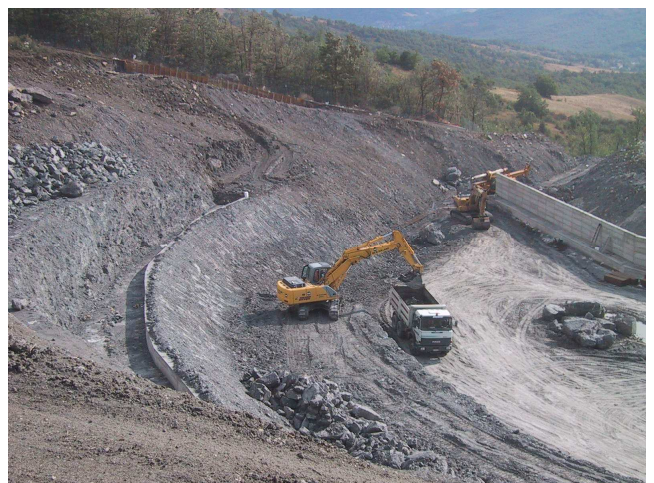
Foto n° 9: Lo scavo del fondovasca n° 8 (con forma ad arco si noti la berlinese di protezione e perimetrazione).
