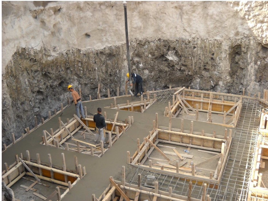
Foto n° 14: Il serbatoio della vasca 9 durante la costruzione (si noti la compartimentazione realizzata particolare diaframma lineare)
