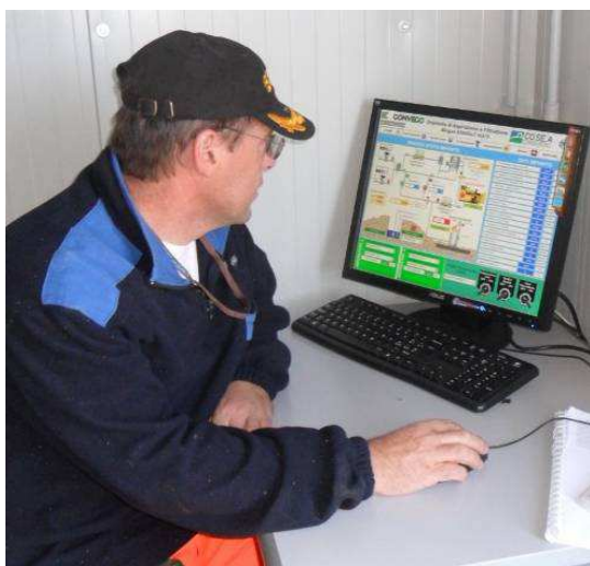
Foto 19: Sistema di monitoraggio Nuovo sistema computerizzato di regolazione automatica della captazione in funzione della qualità del biogas;
