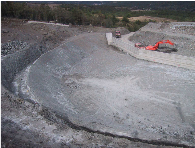
Foto n° 6: Invaso della vasca 8 durante la costruzione
