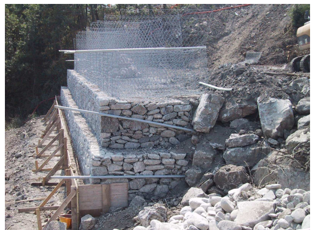
Foto n° 11: La realizzazione delle gabbionate a più ordini
